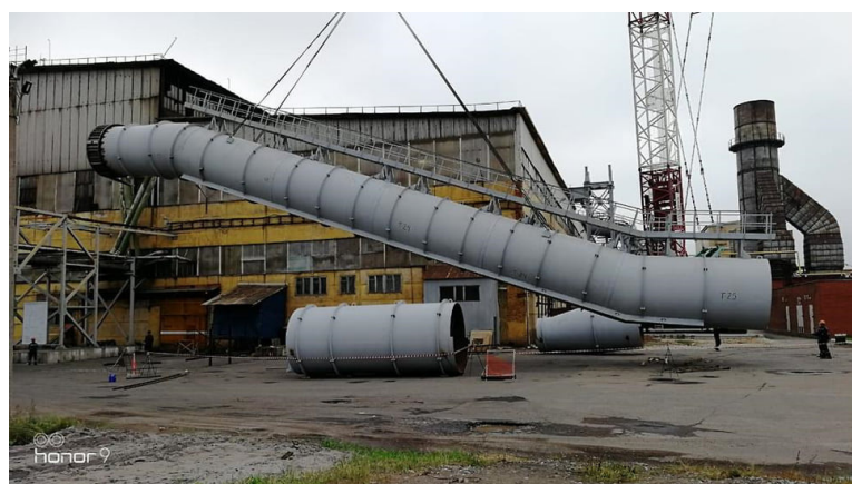
Рисунок 3 – Фильтр перед установкой на ДСП-25
