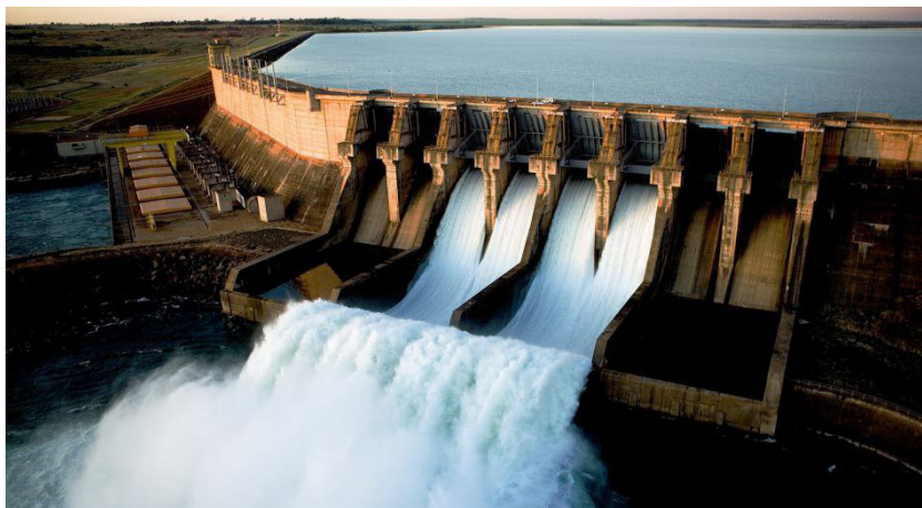
Рисунок 3 – ГЭС плотинного типа
